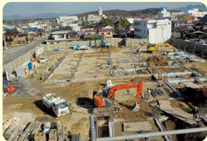
新白松苑建設工事の様相 平成29年12月22日現在
